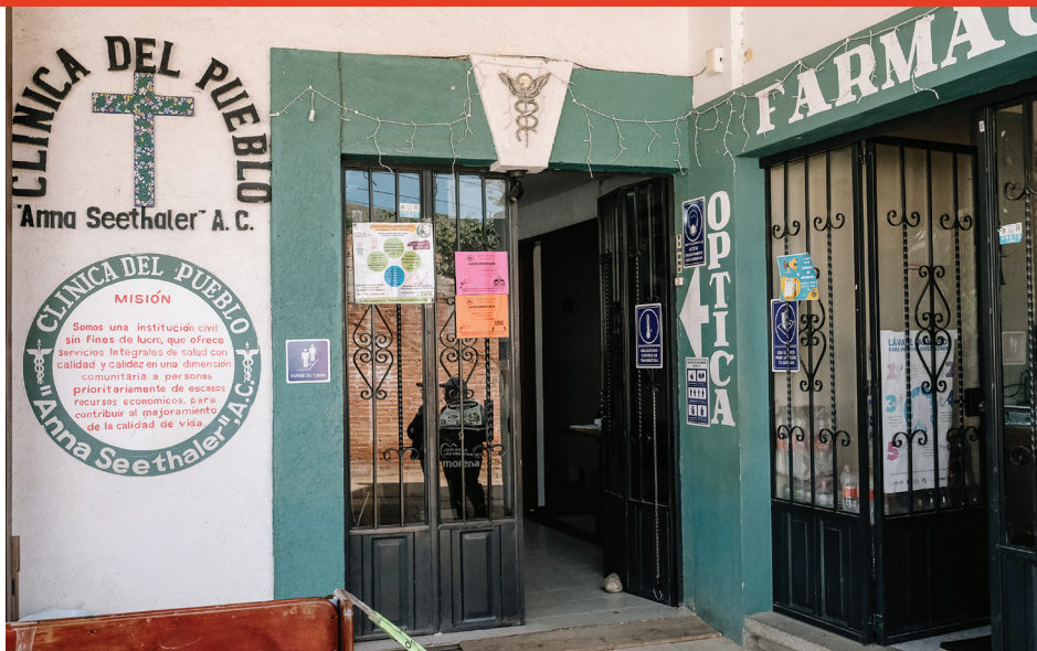
The entrance to La Clínica del Pueblo.
